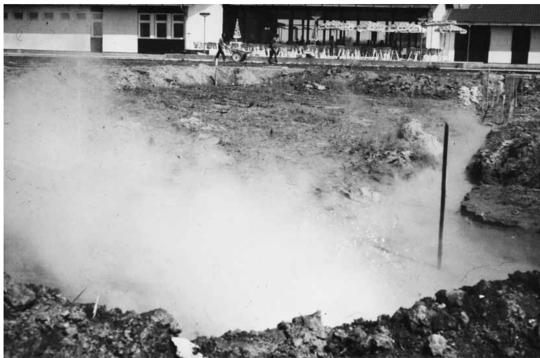
Iskop za izgradnju betonskog bazena, 1975. godine
